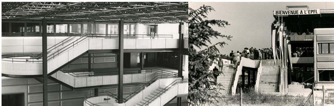
Figure 5 : Intersection entre les circulations horizontales et verticales, ici sous le couvert des bâtiments CE et CM (à g.) et le long des escaliers longeant l'avenue Auguste-Piccard, dont le pendant Sud a été démoli (à d.)
